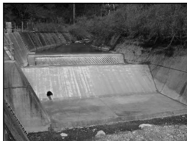
写真-11 員弁川取水工改良後
