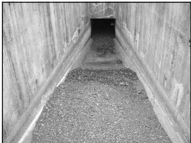
写真-12 員弁川取水工取付水路堆砂状況
