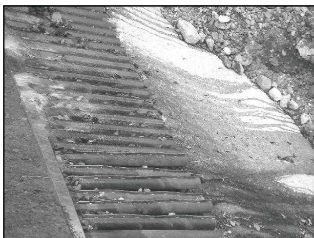
写真-2 員弁川取水工バースクリーン目詰まり
