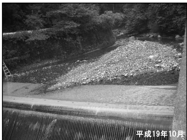
写真-16 河内谷川取水工(改良後)上流土砂堆積
