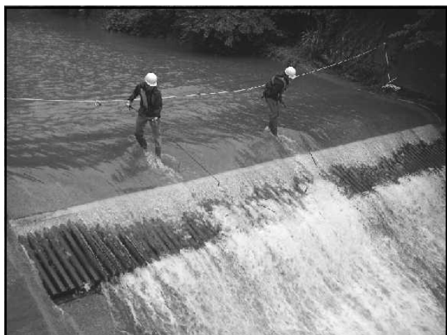
写真-4 人力による員弁川取水工除塵状況
