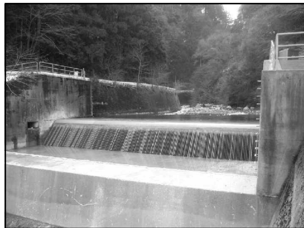
写真-9 河内谷川取水工改良後
