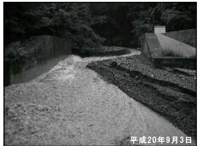
写真-13 冷川取水工取水堰状況(9月3日)
