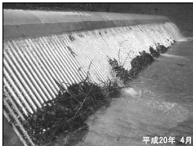
写真-17 員弁川取水工(改良後)塵芥状況
