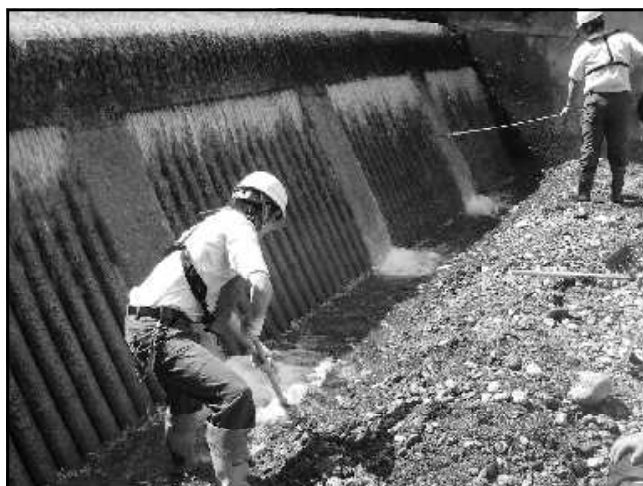
写真-3 人力による河内谷川取水工土砂撤去状況作業であるにもかかわらず、除去後数時間で再び目詰まりが発生した。
