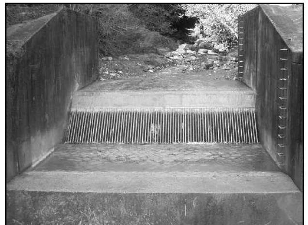
写真-7 冷川取水工改良後
