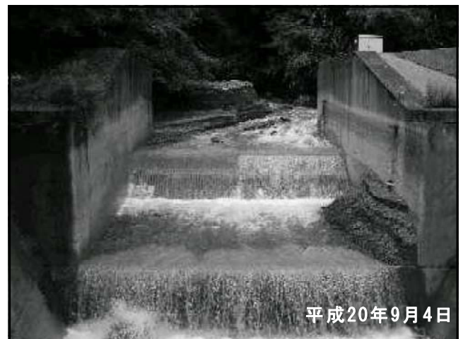
写真-14 冷川取水工取水堰状況(9月4日)
