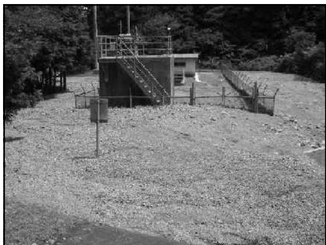
写真-15 冷川取水工構内土砂堆積状況
