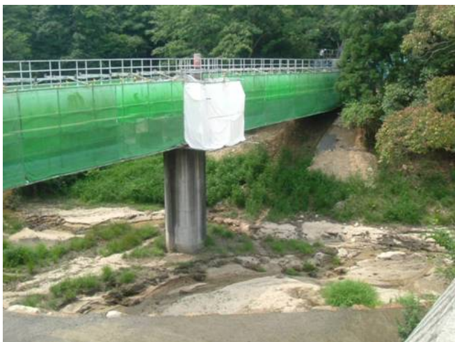
写真-4 第2水管橋（現況）
