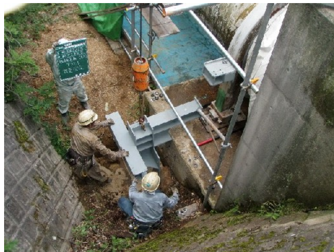
写真-8 落橋防止装置設置状況
