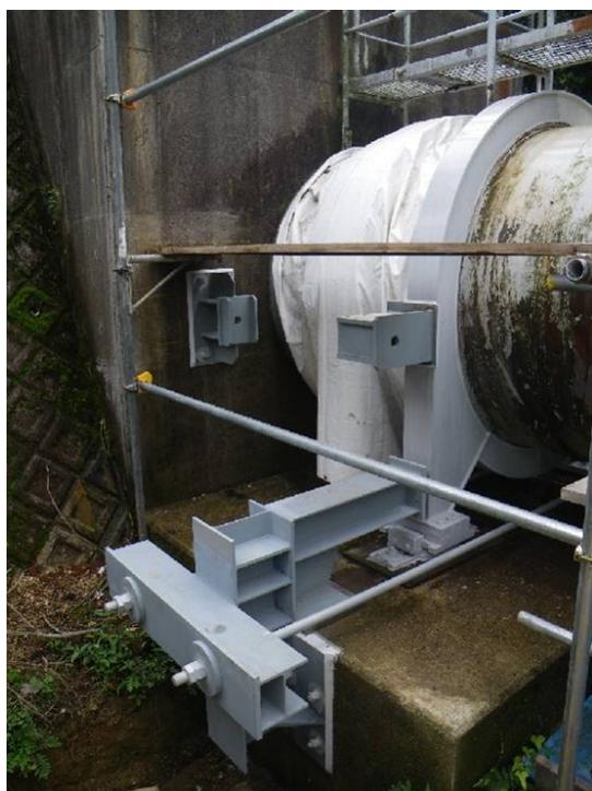
写真-10 落橋防止装置設置
