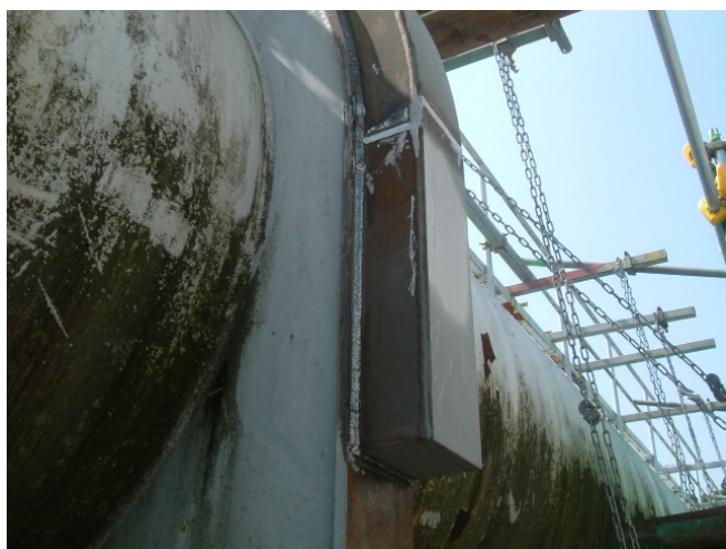
写真-9 リングサポート補強
