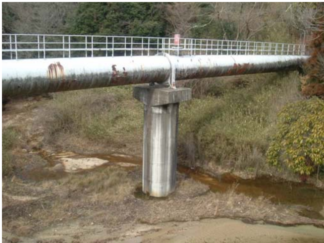
写真-3 第2水管橋（着工前）
