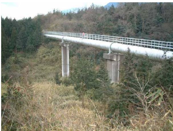
写真-1 杉谷川第1水管橋(上流から下流を望む)
