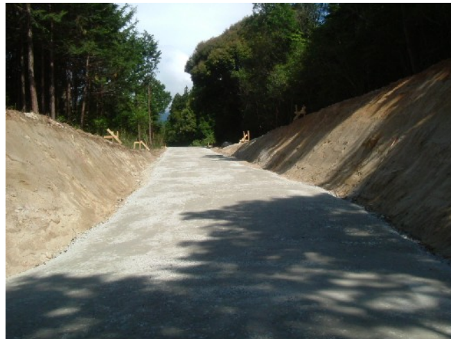
写真-6 仮設道路
