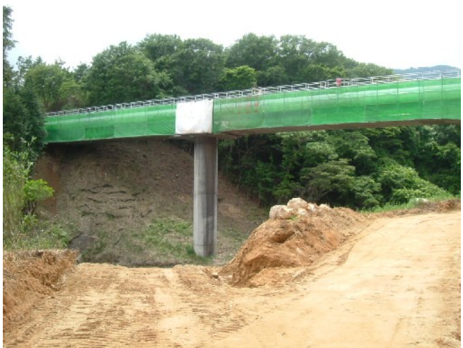
写真-5 仮設道路
