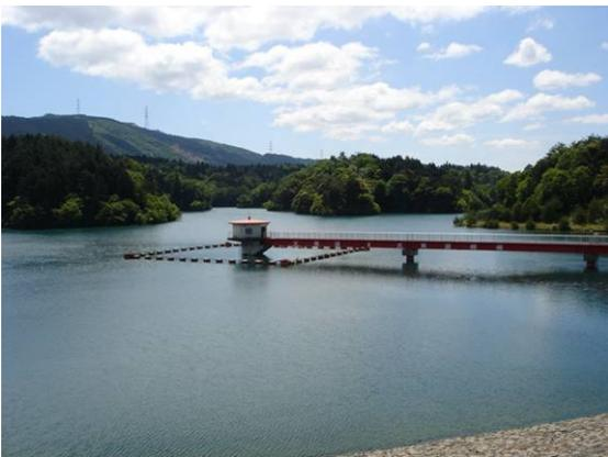
②取水塔です。打上ダム下流の牧田川沿岸の既得用水の補給を行っています。
