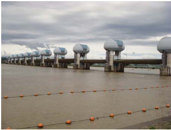
河口堰ゲート全開状況（下流側） 平成23年5月30日9時撮影
