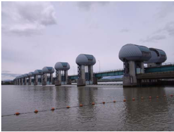
河口堰ゲート状況(下流側) 平成23年5月31日11時撮影
