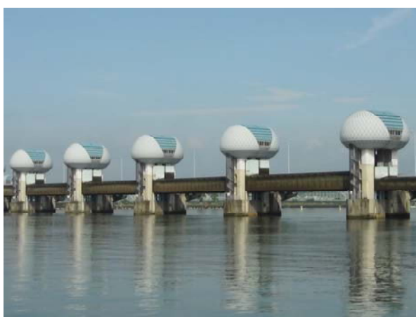
河口堰ゲート全開状況(下流側) 平成23年7月8日9時撮影
