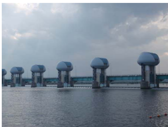
河口堰ゲート状況(下流側) 平成23年7月8日16時撮影
