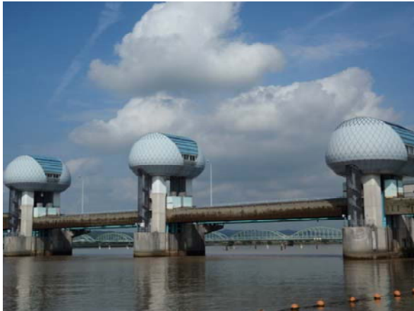
河口堰ゲート状況(下流側) 平成23年8月24日9時撮影
