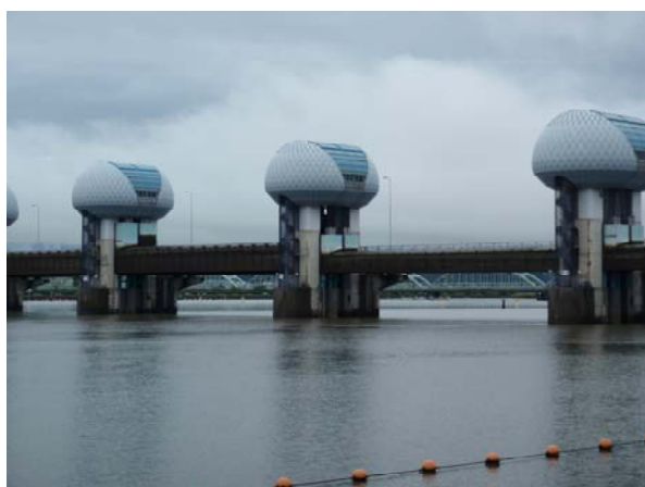
河口堰ゲート全開状況（下流側） 平成23年9月5日9時撮影
