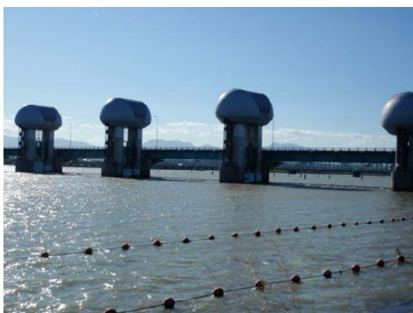
河口堰ゲート全開状況（下流側） 平成23年9月6日16時撮影
