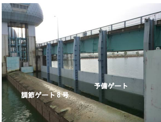
【予備ゲートの設置が完了した状況】 (調節ゲート8号)
