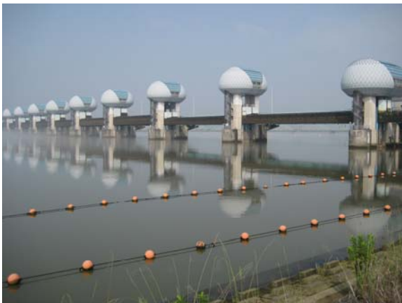
河口堰状況写真(下流側) 平成25年7月30日8時30分撮影
