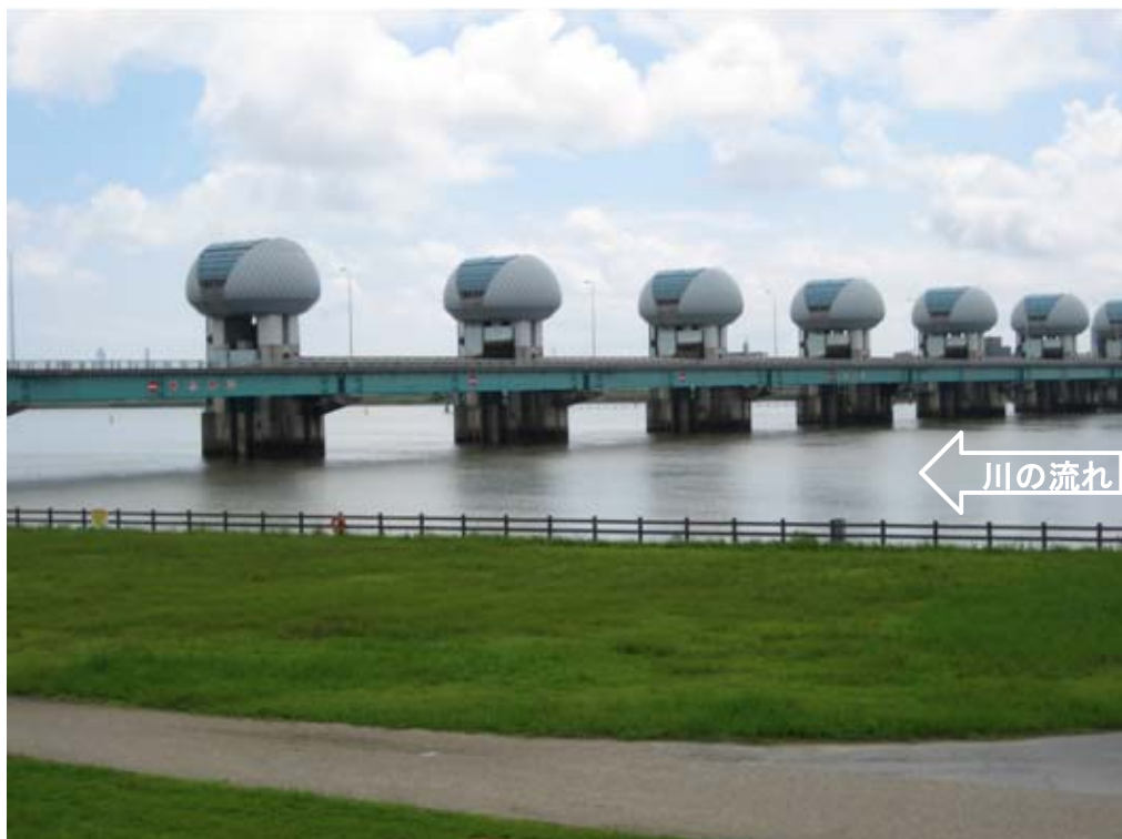
ゲート全開操作時の長良川河口堰(堰上流側)
