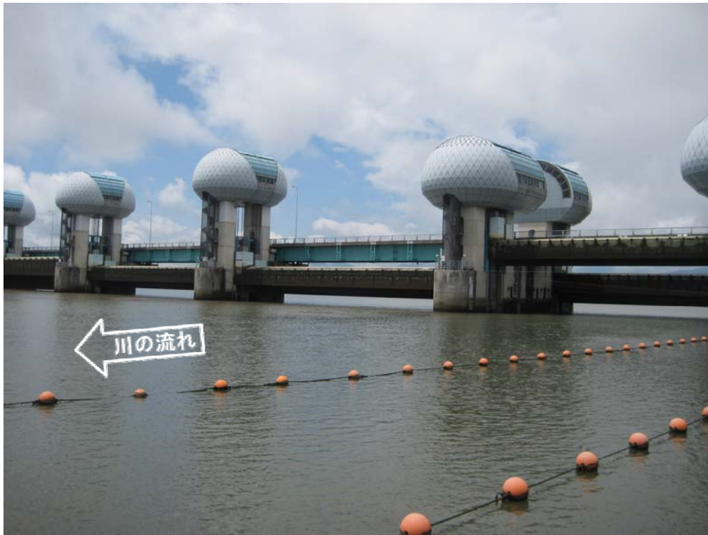
ゲート引上途中の長良川河口堰(堰下流側)
