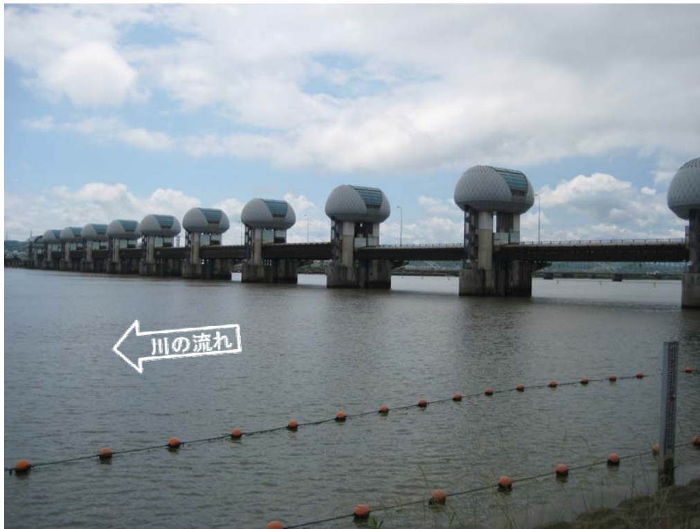
ゲート引上完了後の長良川河口堰(堰下流側)
