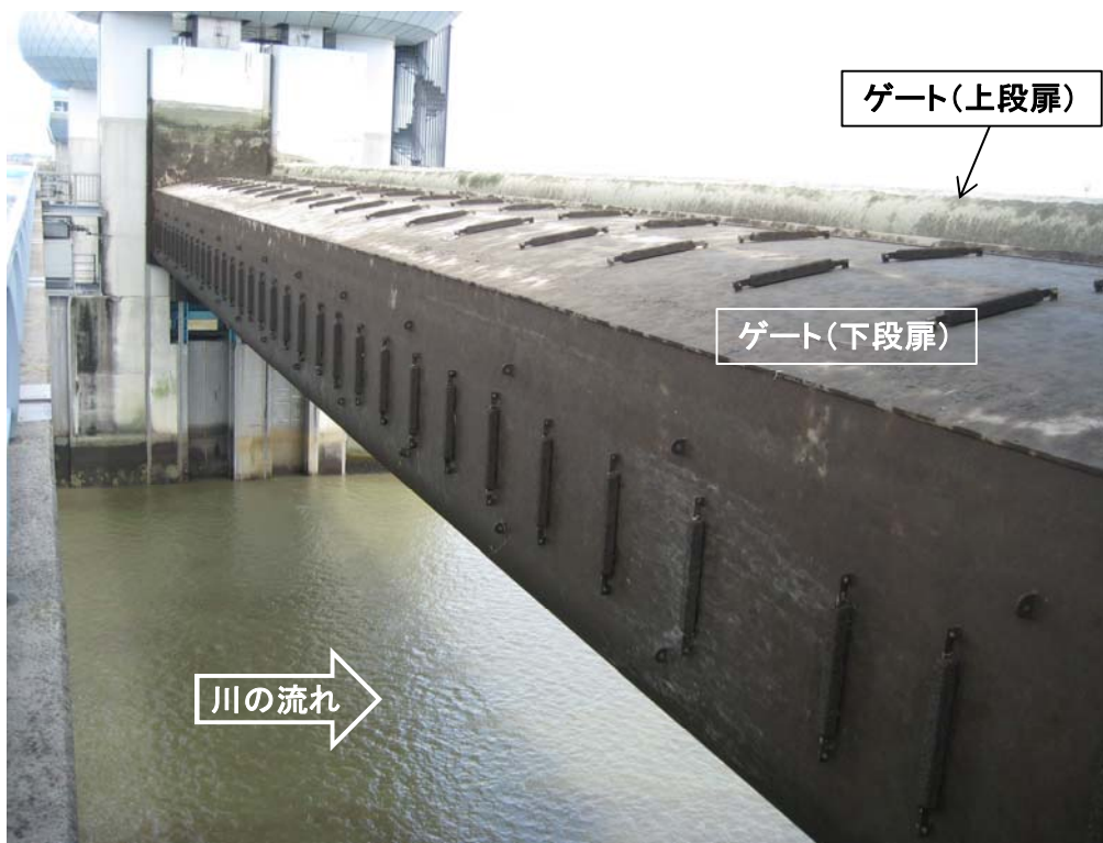
ゲート引上完了後の長良川河口堰(ゲート上段扉・下段扉)
