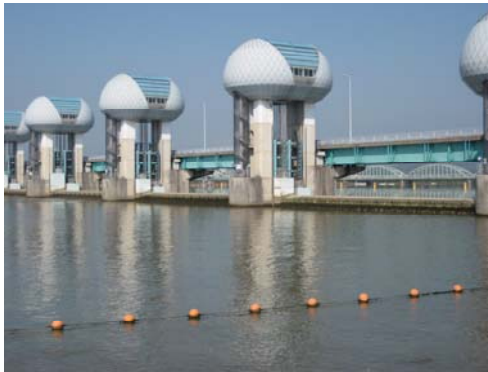
全開操作終了後の河口堰(下流側) 平成25年8月7日8時撮影
