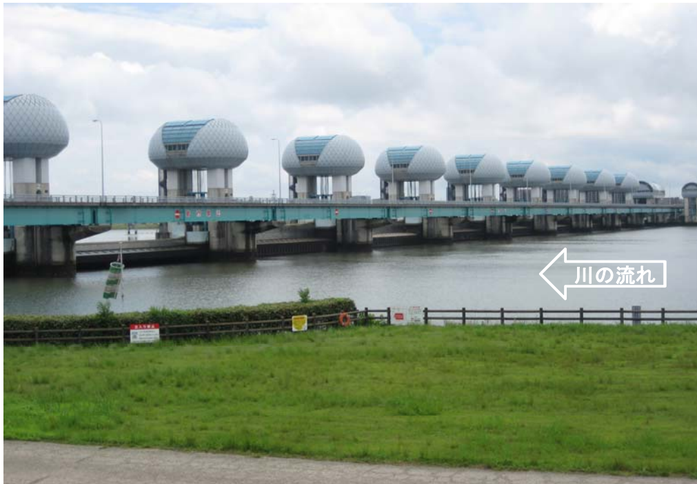
ゲート全開操作開始前の長良川河口堰(堰上流側):アンダーフロー状態
