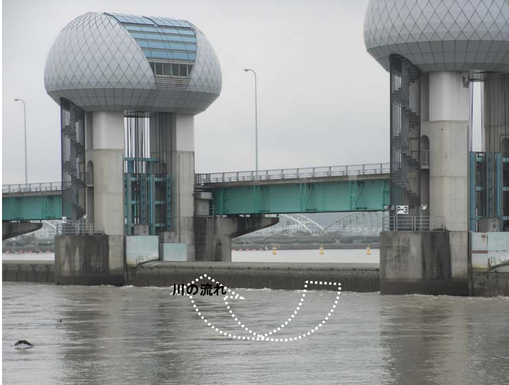
ゲート全開操作終了後の長良川河口堰(アンダーフロー操作に切り替え) 8月12日11時撮影
