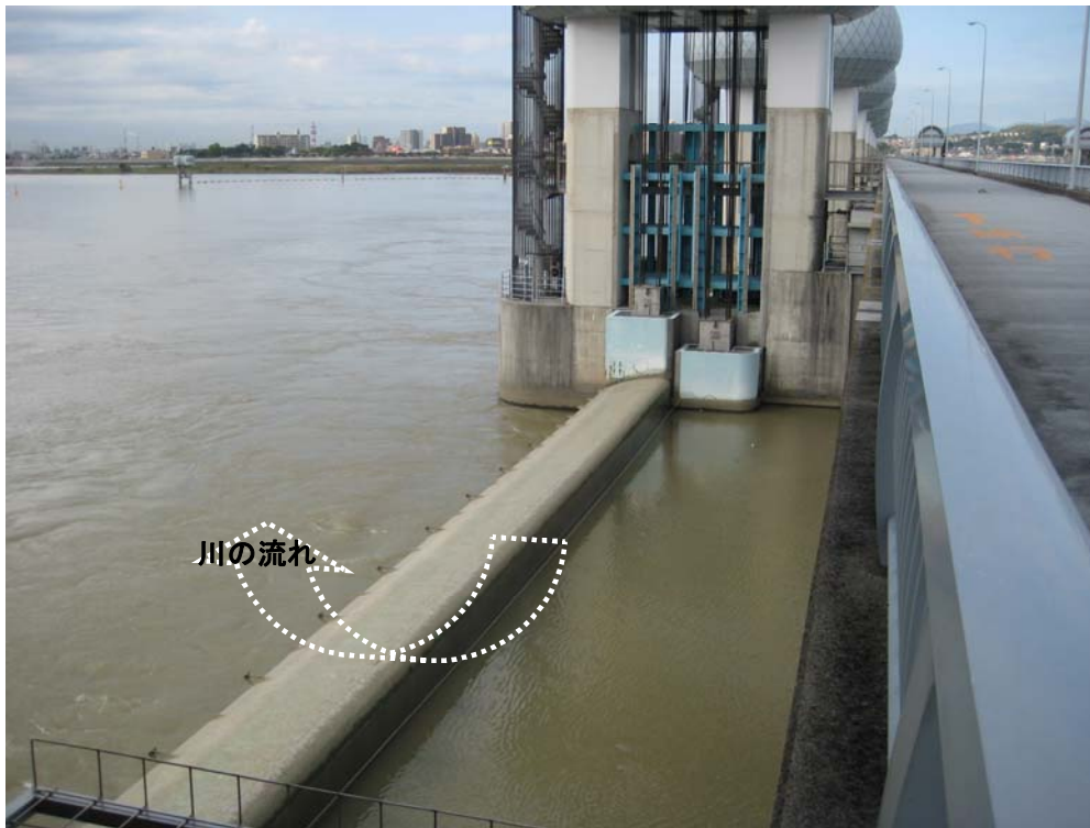
ゲート全開操作終了後の長良川河口堰(アンダーフロー操作に切り替え) 10月15日8時撮影
