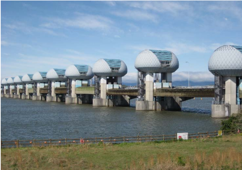
ゲート全開操作時の長良川河口堰(堰下流側)
