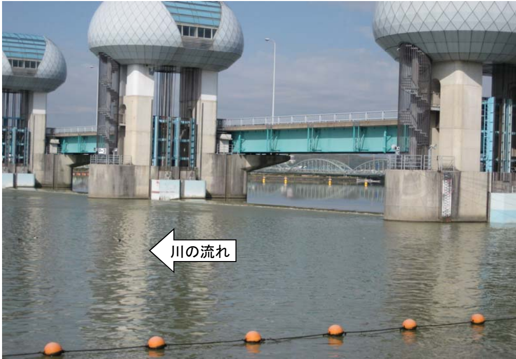
ゲート全開操作終了後の長良川河口堰(オーバーフロー操作に切り替え) 4月22日7時撮影
