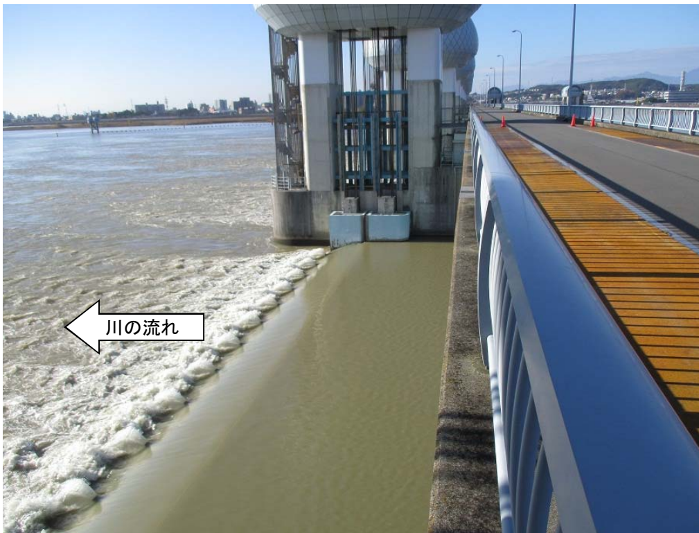
ゲート全開操作終了後の長良川河口堰（オーバーフロー操作に切り替え）
