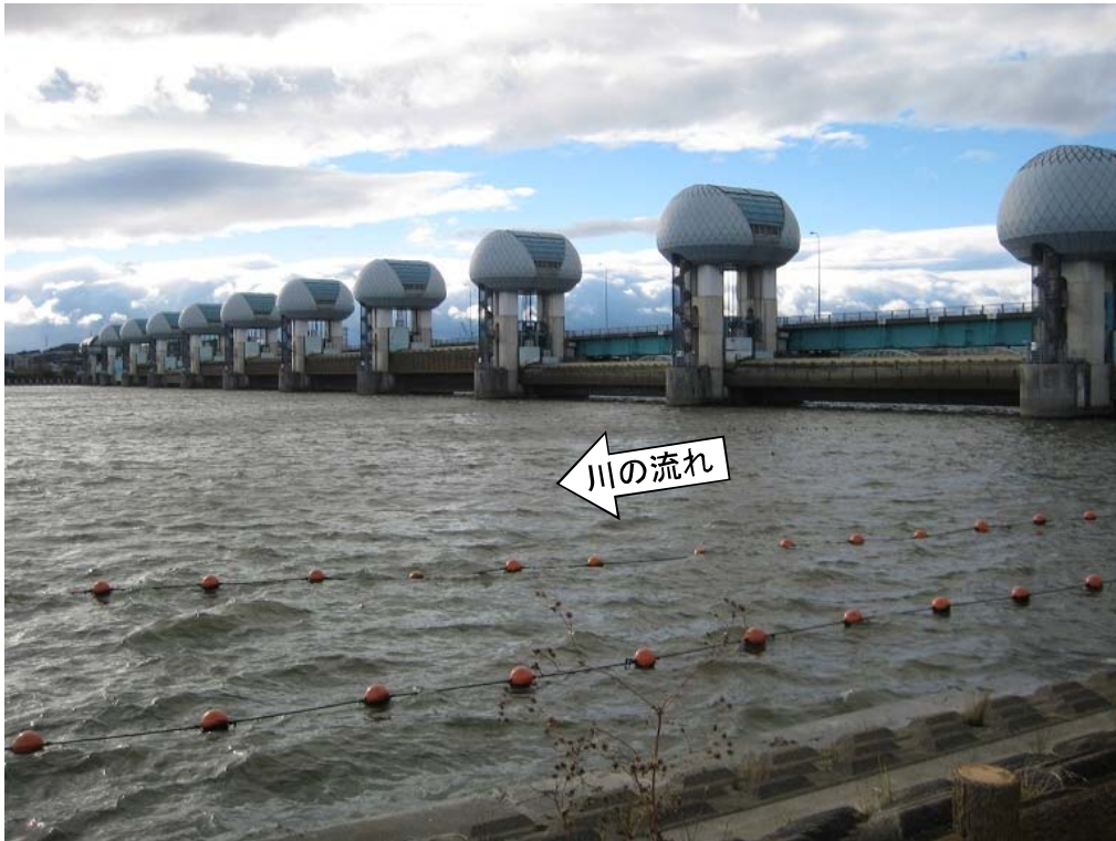
ゲート全開操作時(ゲート水切り状態)の長良川河口堰 (堰下流側)
