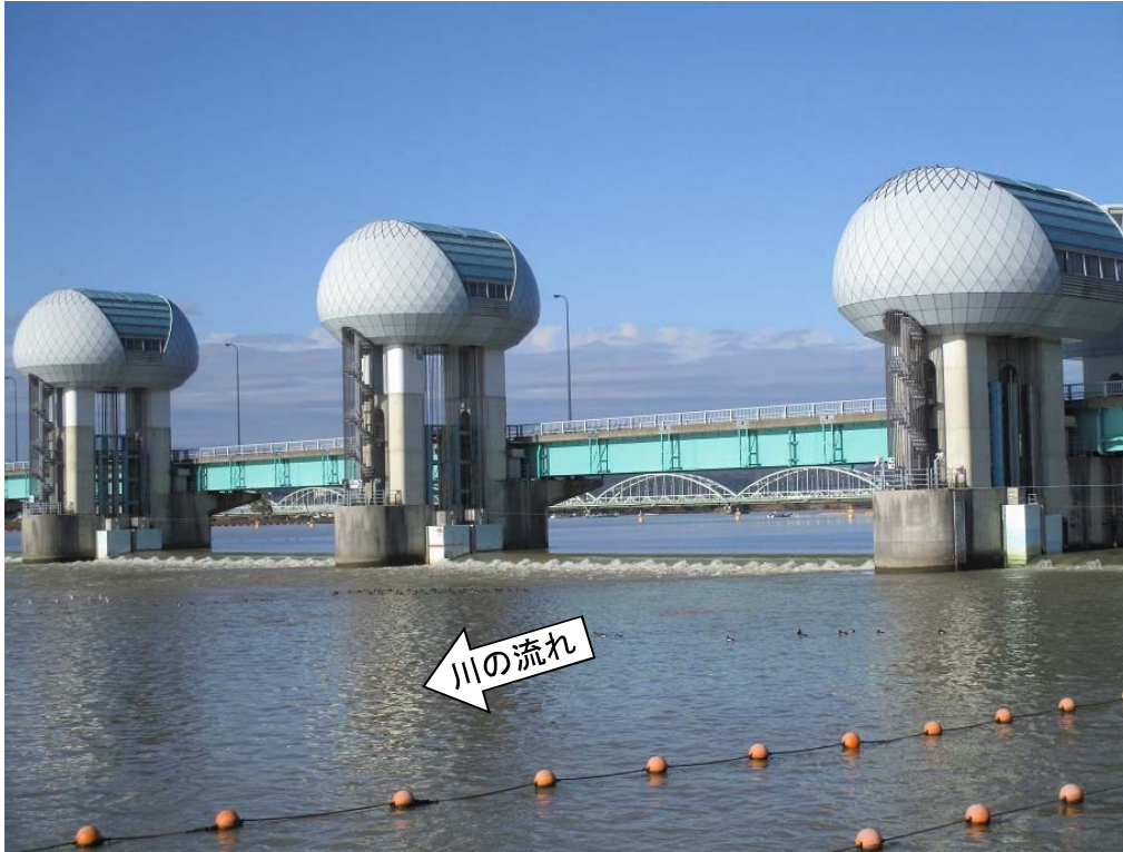
ゲート全開操作終了後の長良川河口堰（オーバーフロー操作に切り替え）
