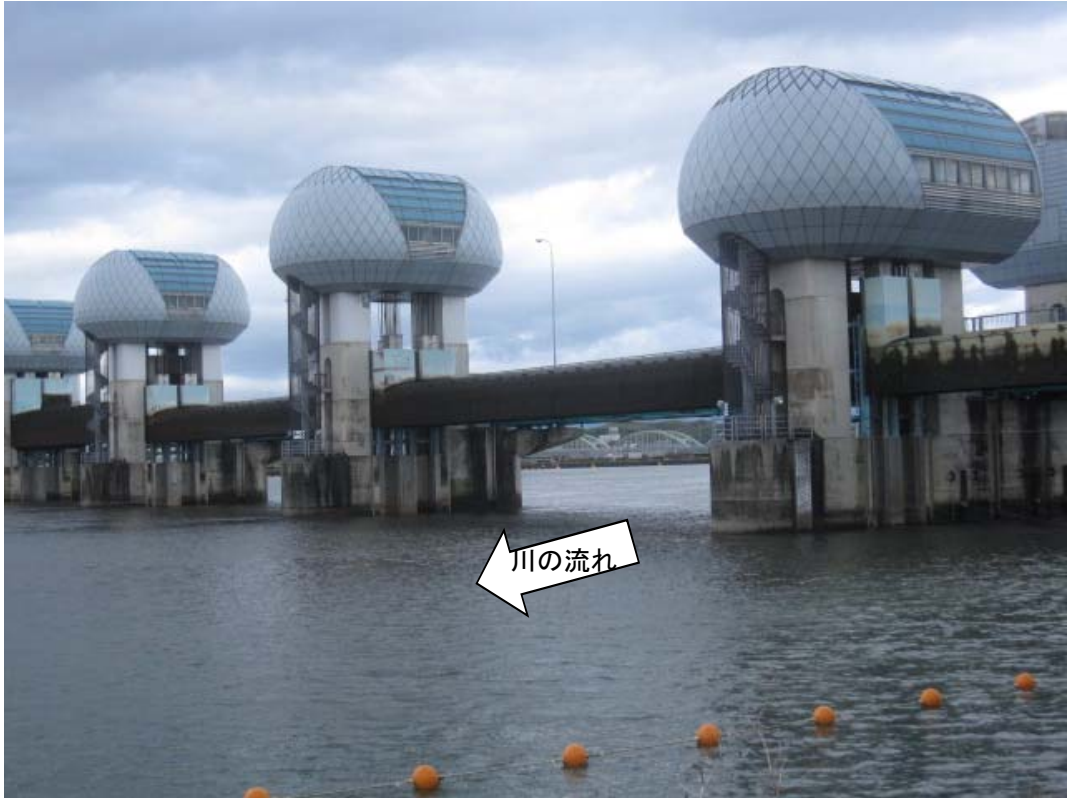
ゲート全開操作時の長良川河口堰(堰下流側)
