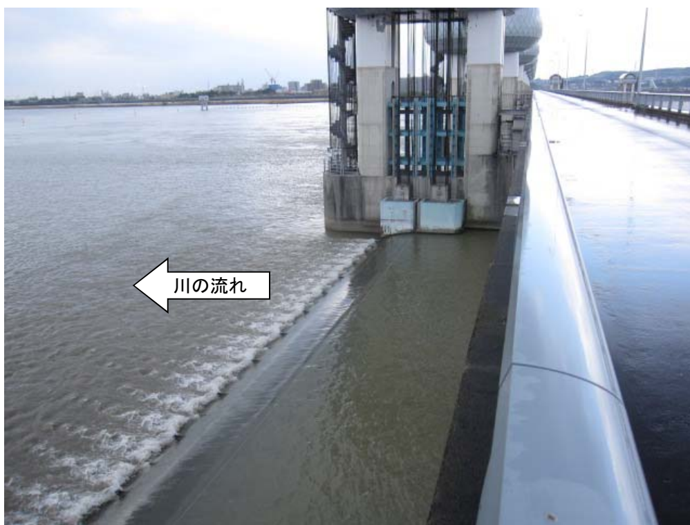
ゲート全開操作終了後の長良川河口堰(オーバーフロー操作に切り替え) 4月19日7時撮影
