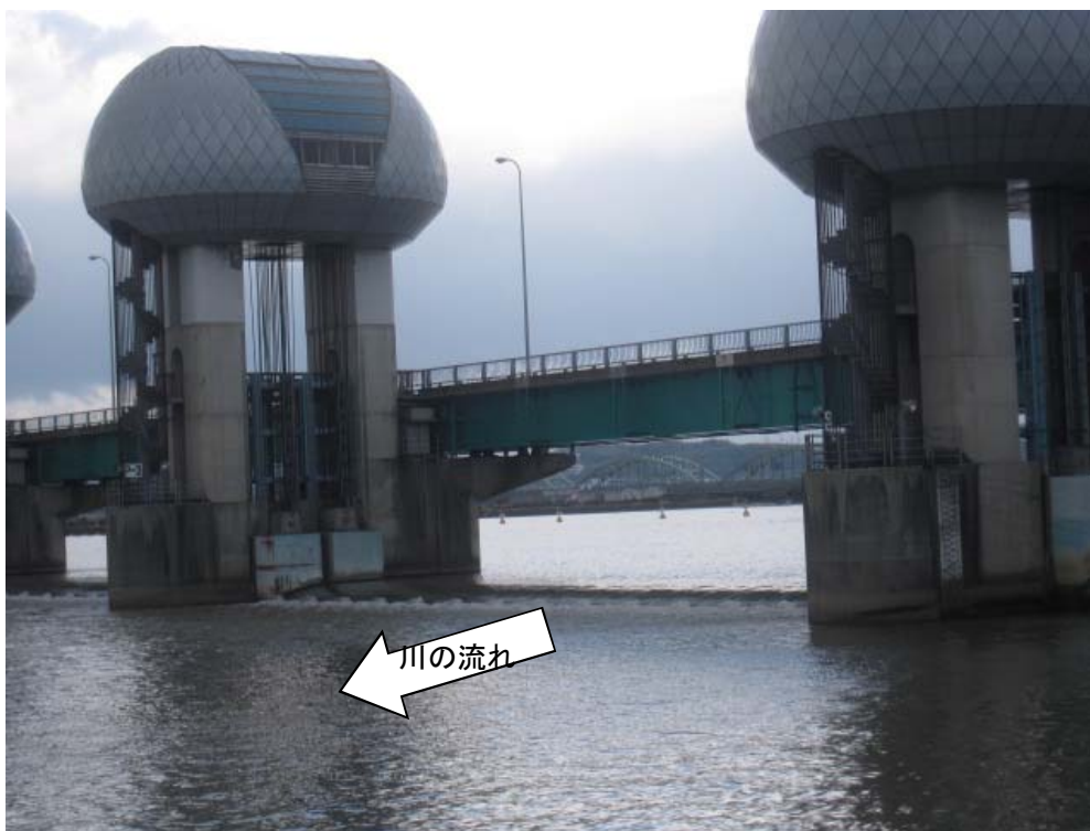
ゲート全開操作終了後の長良川河口堰(オーバーフロー操作に切り替え) 4月19日7時撮影
