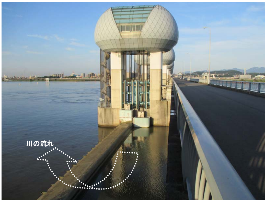
ゲート全開操作終了後の長良川河口堰（アンダーフロー操作に切り替え） 8月20日 6時撮影
