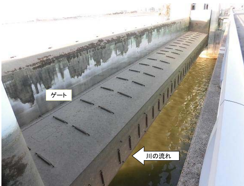
ゲート全開中の長良川河口堰
