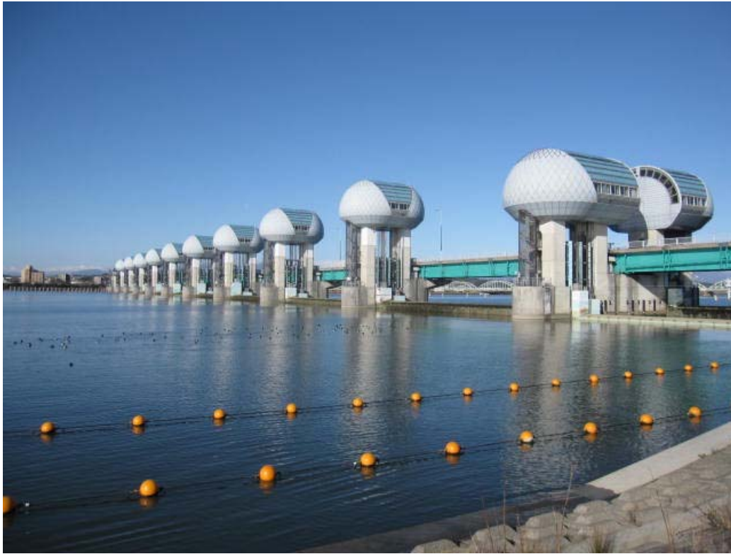
ゲート全開操作終了後の長良川河口堰
