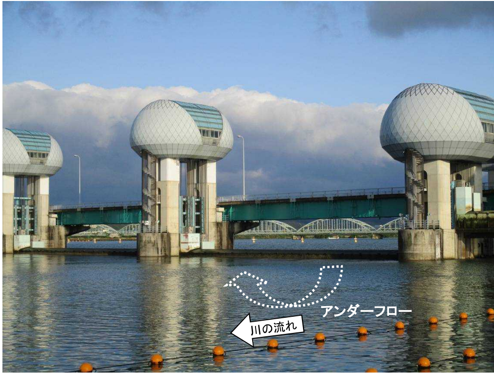
ゲート全開操作終了後の長良川河口堰（堰下流側） 5月14日 6時撮影
