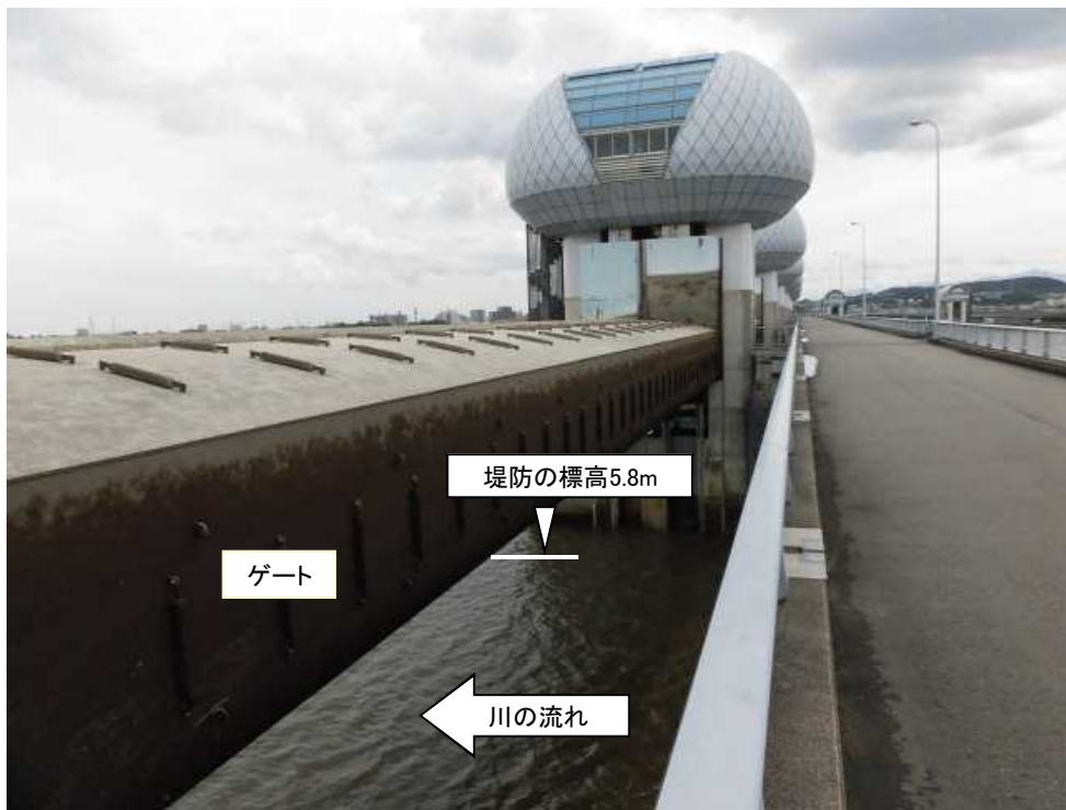
ゲート全開操作開始後の長良川河口堰（堤防より高い位置にゲートを引き上げ）
