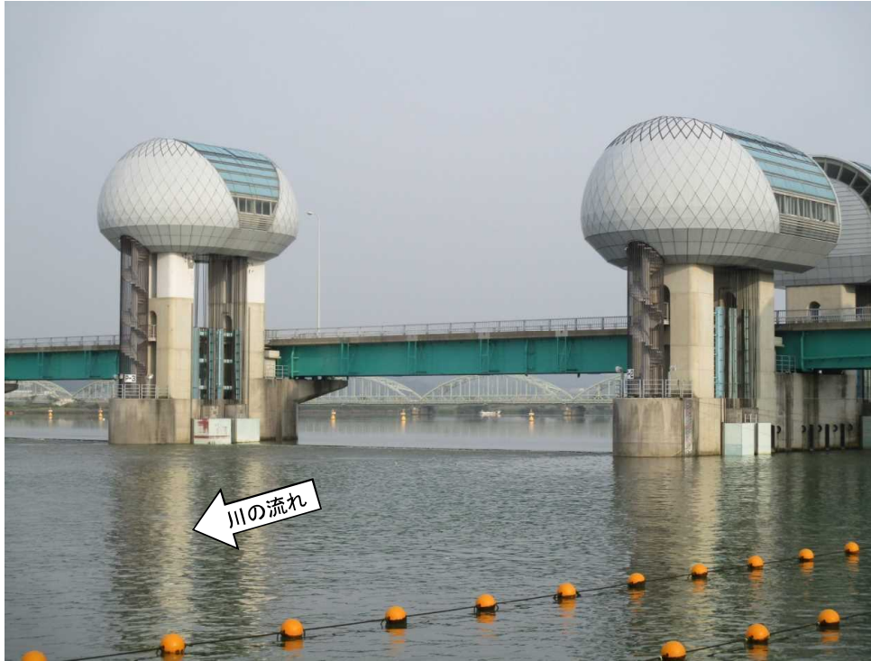
ゲート全開操作終了後の長良川河口堰（オーバーフロー操作に切り替え） 7月5日 6時撮影
