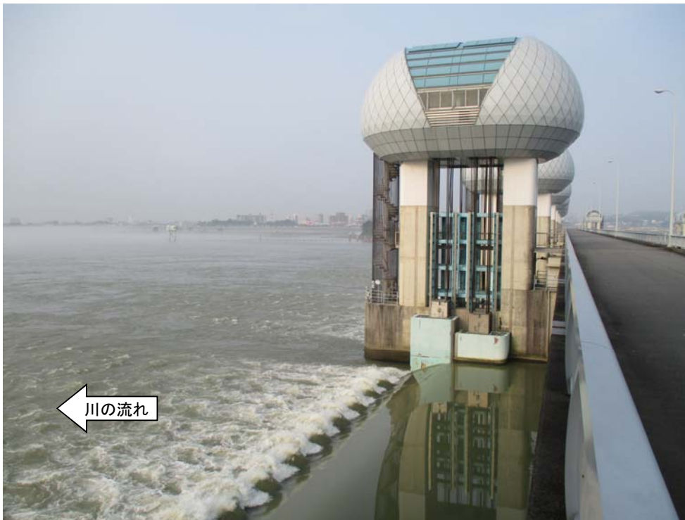
ゲート全開操作終了後の長良川河口堰（オーバーフロー操作に切り替え） 7月29日 7時撮影
