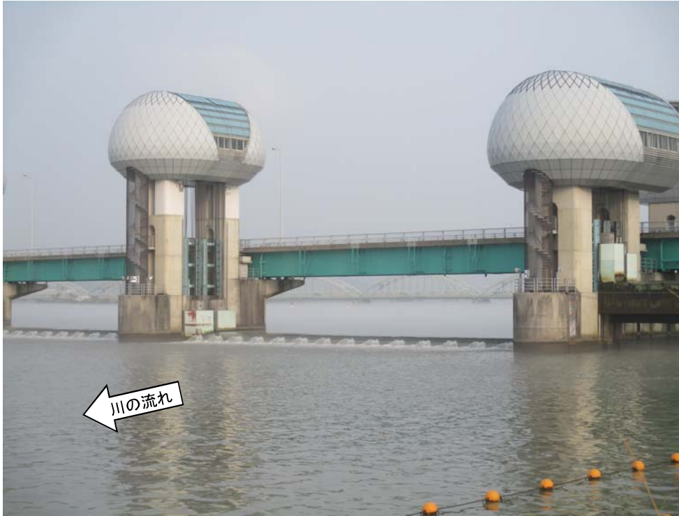
ゲート全開操作終了後の長良川河口堰（オーバーフロー操作に切り替え） 7月29日 7時撮影
