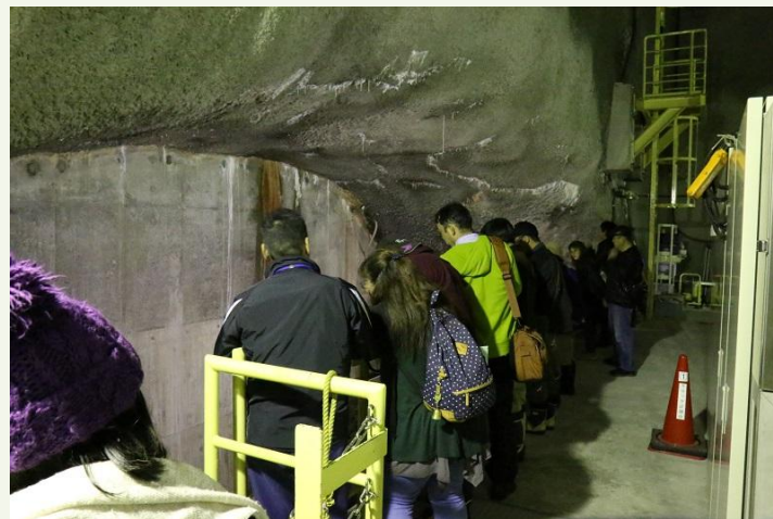
当日はダム堤体内の見学会も実施し、喜んで頂きました！
