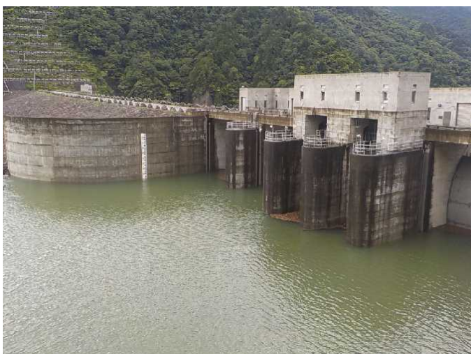
徳山ダム洪水吐（貯水池側）
