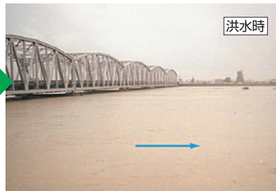
▲揖斐川右岸堤防から揖斐大橋を望む(平成14年7月)
