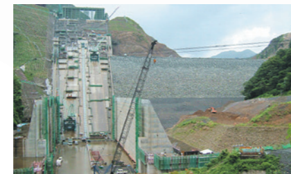
▲洪水吐き工事 (平成16年6月)
