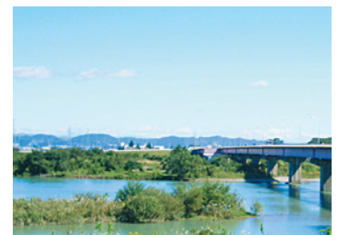
▲平成16年10月揖斐川通常の流れ(平野庄橋付近)
