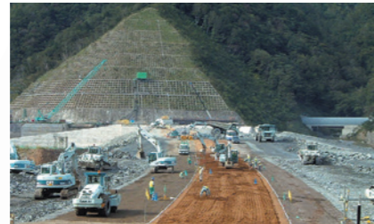
▲コア・フィルタ・ロックの盛立工事のようす (平成17年9月)
