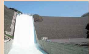
▲試験湛水(試験放流)(平成20年4月)
