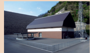
▲徳山水力発電所
