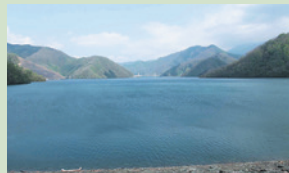
▲試験湛水(満水EL.401m)(平成20年4月)
