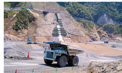
▲材料を運ぶ大型重機 (平成16年8月)
