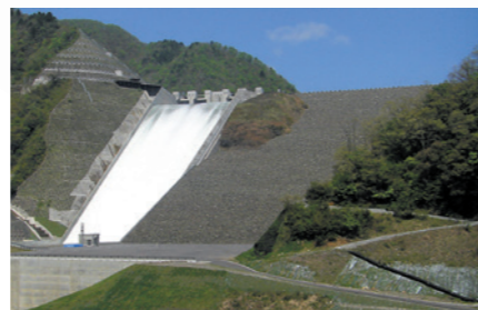
▲試験放流時の洪水吐・下流より (平成20年4月)
