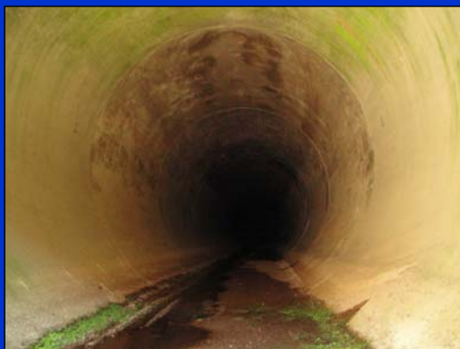
1号仮排水路トンネル (閉塞箇所まで約600m、高さ約9m)
