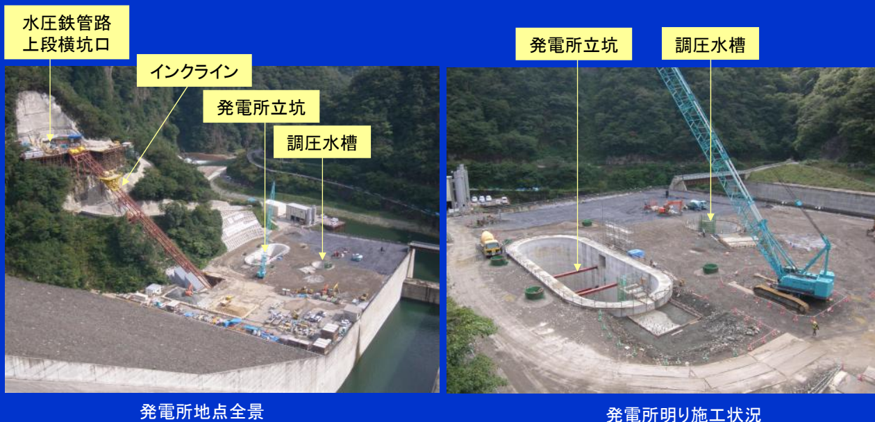
徳山水力発電所工事施工状況(ダムサイト下流 平成22年10月)
