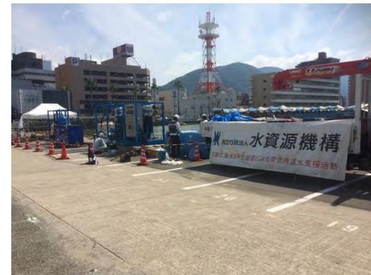
(可搬式浄水装置設置)
