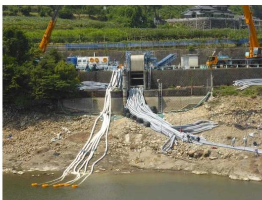
写真一水資源機構派遣ポンプ車他による緊急取水状況（写真は8月8日撮影）
