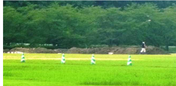
土砂受入状況
