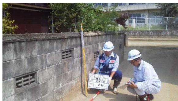
写真一朝倉市杷木の家屋土砂の被災状況調査（写真は7月28日撮影）
