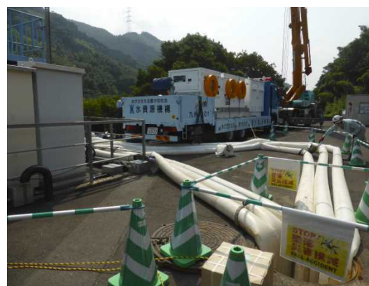
写真一水資源機構派遣ポンプ車他による緊急取水状況（写真は8月8日撮影）
