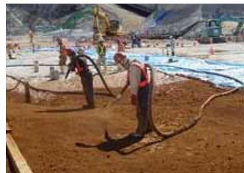
湿式吹付機械による施工状況
