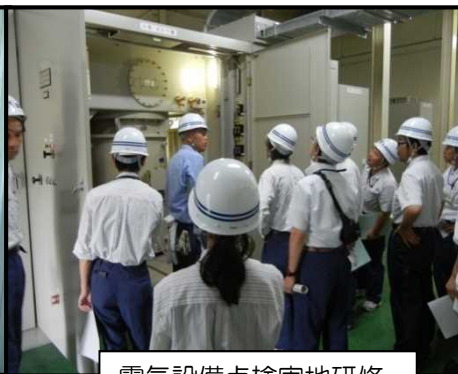
電気設備点検実地研修
