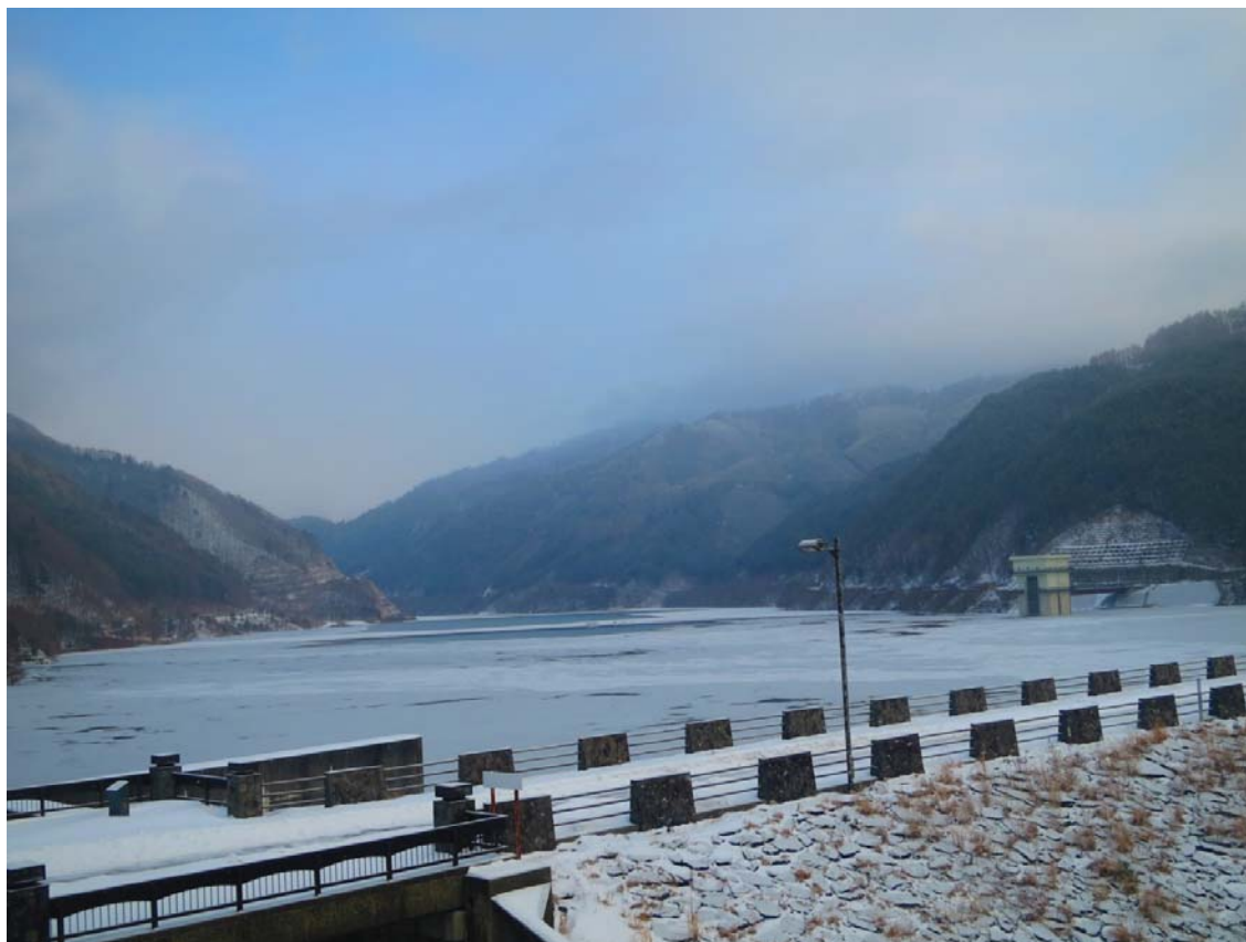
ダム直上流部
