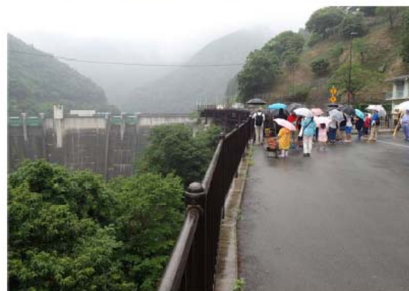
二瀬ダムを下流より望む
