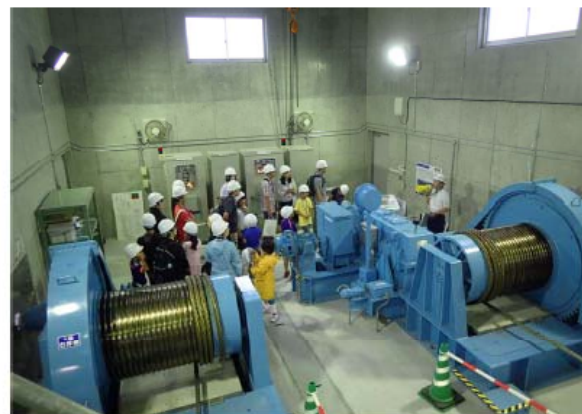
滝沢ダム非常用ゲート室
