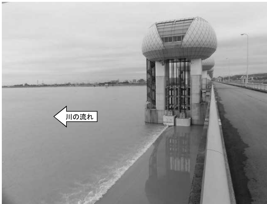
ゲート全開操作終了後の長良川河口堰（オーバーフロー操作に切り替え） 9月 12日 7時00分撮影
