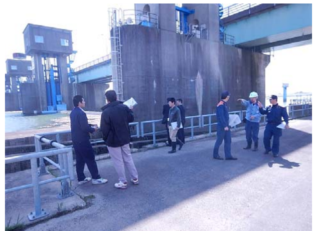
堰周辺高水敷き（右岸）
