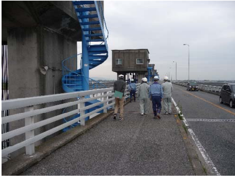
（筑後大堰管理橋の確認状況）
