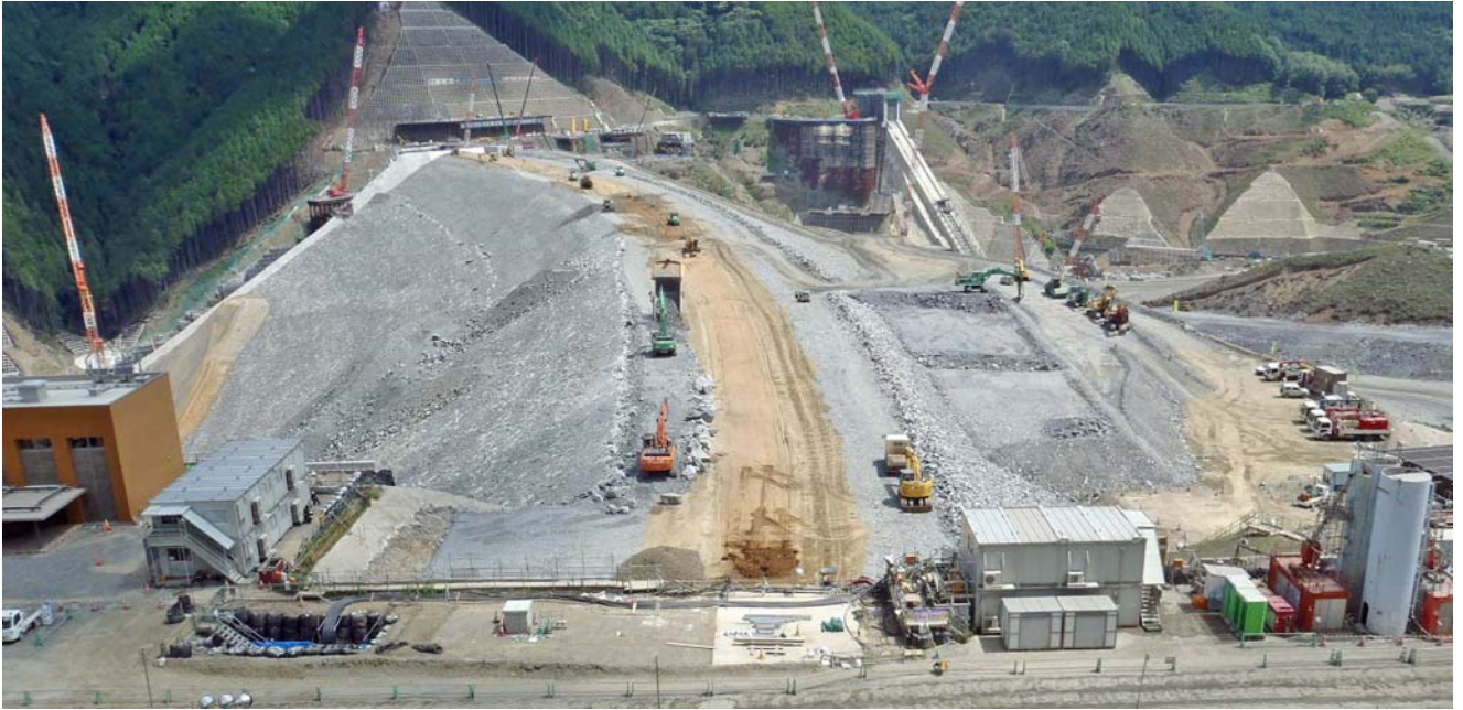
ダムサイト左岸より
