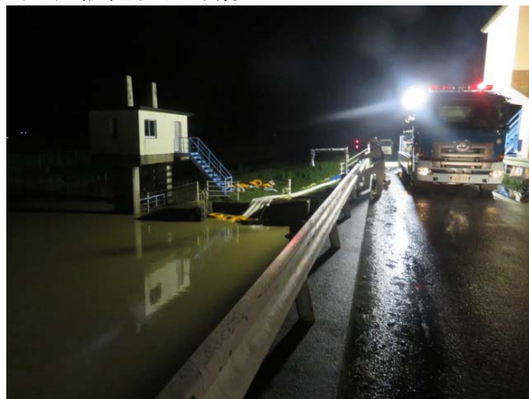
(2) 設置状況外観
