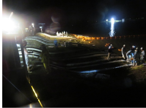
(6) ポンプの増設作業
