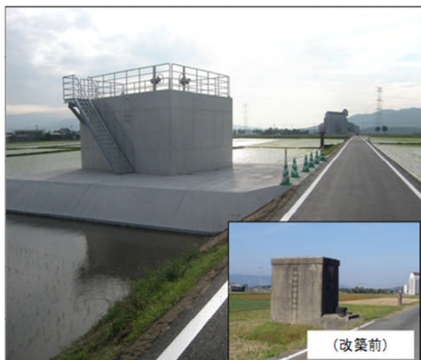
写真－８ 減勢工改築状況 【夜須第3減勢工改築工事】
