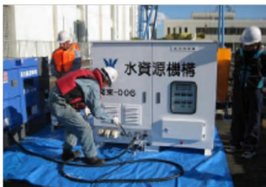
⑤ポンプパッケージ（ 10\text{m}^3/\text{min} 級）配線中
