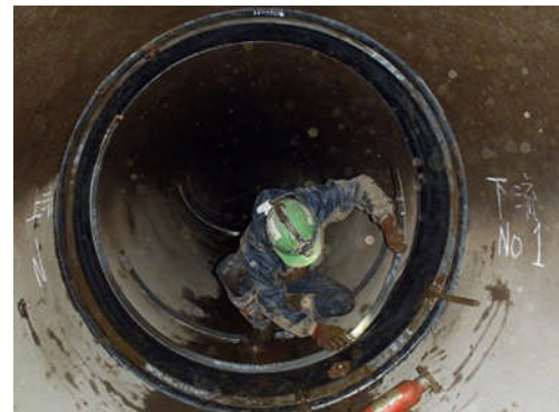
⑥継手補強材設置 (備蓄資材使用)
