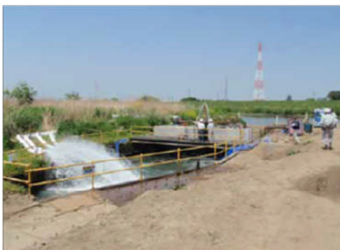
③ポンプ車による給水状況
