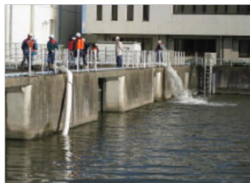
⑥ポンプパッケージ実送水確認
