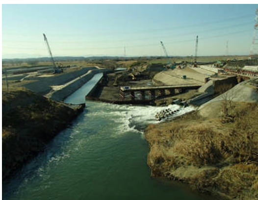
③下流部改築工事状況
