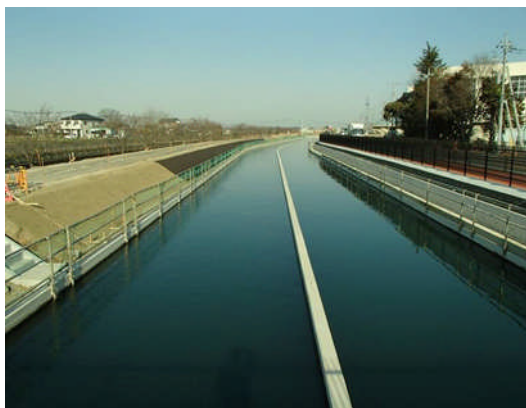
①上流部改築工事状況
