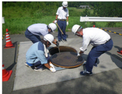
漏水対応訓練
