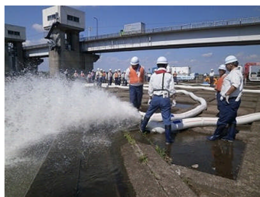
④ポンプ車実送水確認
