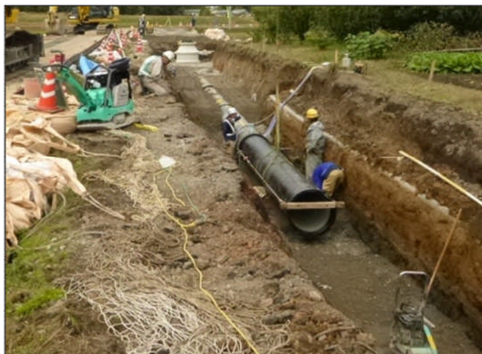
写真－5 ダクタイル鋳鉄管布設状況 【深萱工区改築工事（老朽化対策）】
