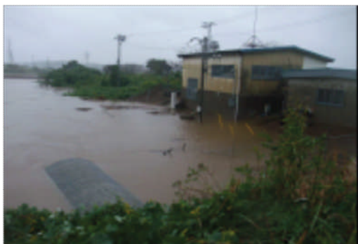
①臼井第二機場周辺の湛水状況
