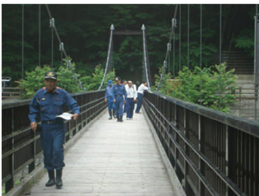
上流端広場付近の点検（滝沢ダム）
