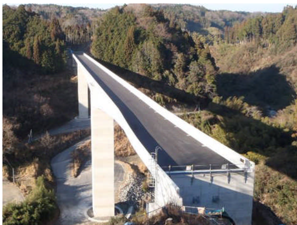
写真－3 付替県道工事（猫また大橋）実施状況（川上ダム）
