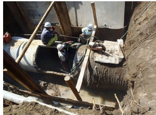
④既設P C管撤去状況
