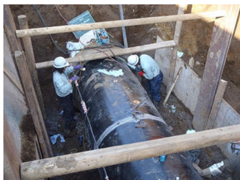
⑤鋼管設置 (備蓄資材使用)
