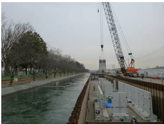
②中流部改築工事状況
