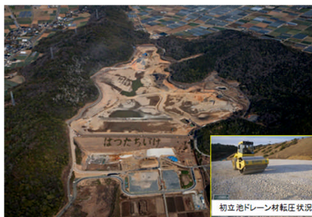
写真－７ 初立池耐震補強状況 【初立池耐震補強工事（耐震補強）】
