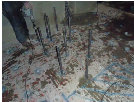
鉄筋挿入工
