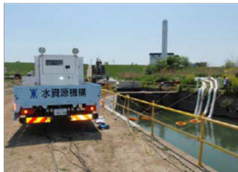
②ポンプ車配備状況
