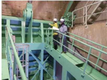
ゲート設備の劣化・損傷確認 (高山ダム)
