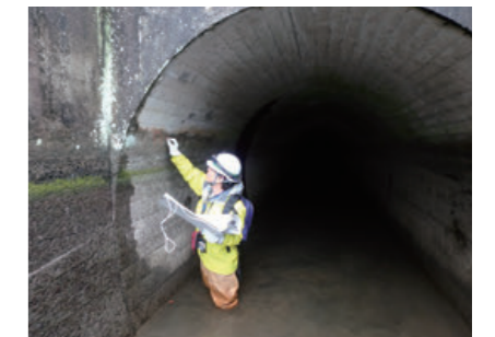
水路トンネルの点検(両筑平野用水)
