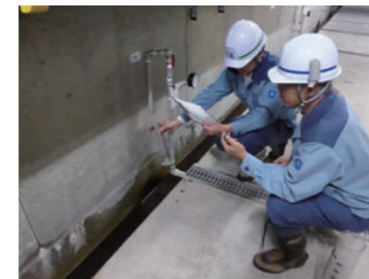
堤体内の漏水量測定(大山ダム)
