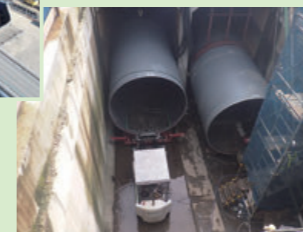
鋼管を設置した宗岡副水路
