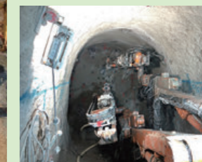
水路トンネル工事
