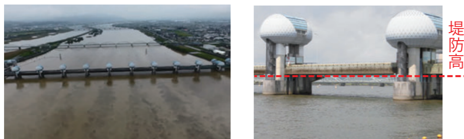
ゲートを河川堤防より高く引き上げて、洪水を安全に流下させる長良川河口堰
