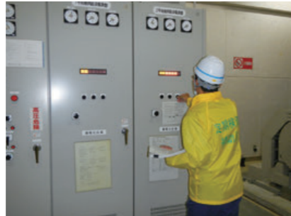
受変電設備の動作確認 (早明浦ダム)
