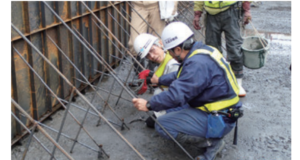
ダム本体工事施工監理
