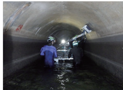
(左:通水点検装置車による背面画像撮影、右:通水台車による背面空洞調査) ICT等新技术を活用した機能診断調査(香川用水)
