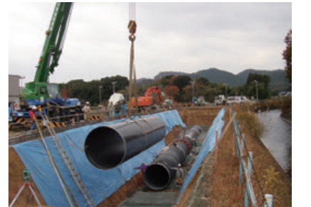
豊川用水二期事業(バイパス水路の設置)
