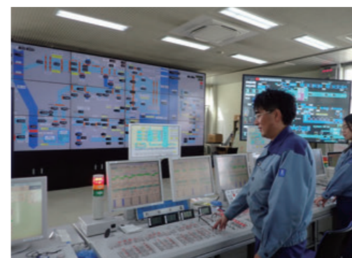
集中管理による適切な用水供給(利根導水路)
