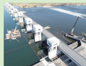
耐震補強工事中の利根大堰
