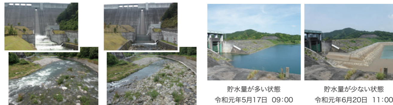
補給を行っている状況 補給を行っていない状況 ダムからの補給(大山ダム)
