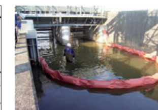
水質事故時のオイルフェンス(木曾川用水)
