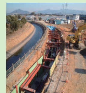
併設水路工事
