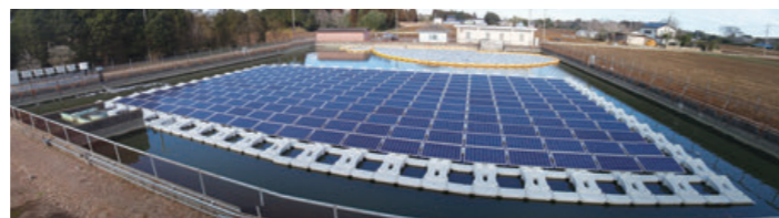
太陽光発電設備(北総東部用水)
