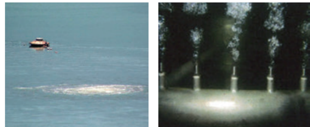
曝気循環設備の稼働状況(左:水面 右:吐出口)
