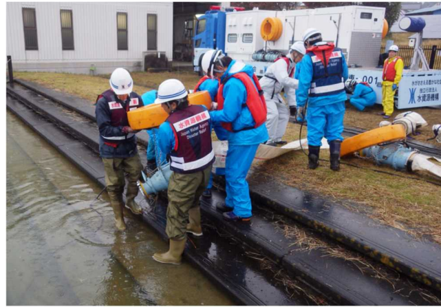
ポンプ車設営訓練
