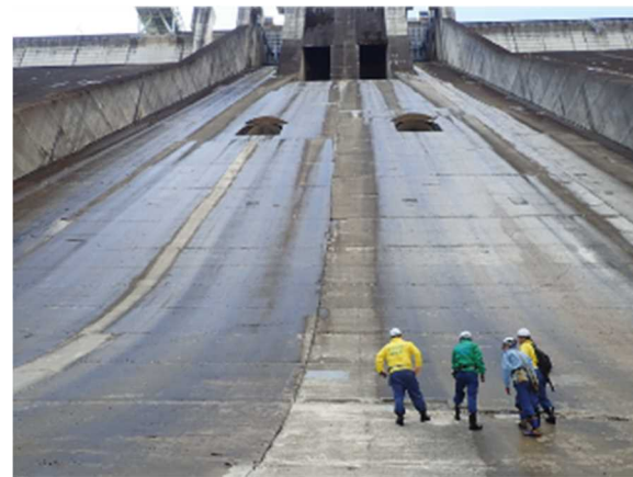
ダム堤体下流面の健全性確認（下久保ダム）
