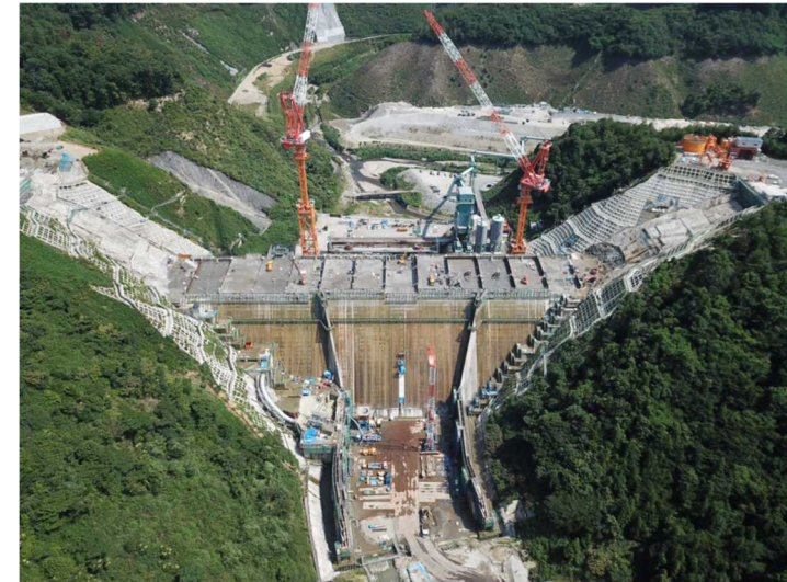
川上ダム建設事業
