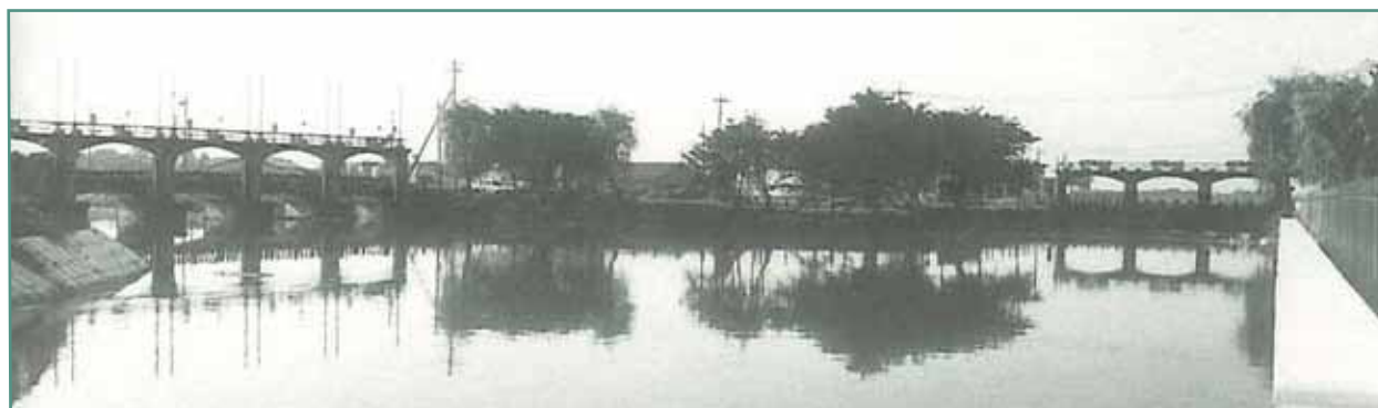
昭和30年代の十六間堰と八間堰(左:十六間堰、右:八間堰、見沼代用水土地改良区)
