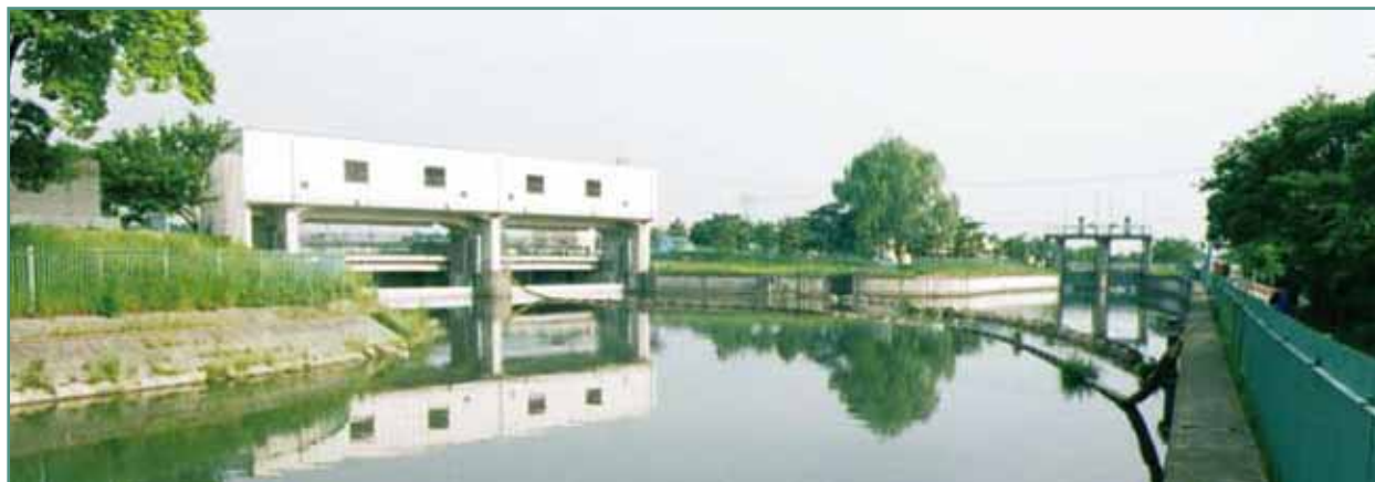
現在の十六間堰と八間堰(左:十六間堰、右:八間堰)。改修を重ねた結果、現在の八間堰は約四間(7m)となった。
