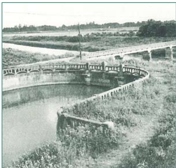
昭和30年代の柴山伏越。当初木製だった伏越は、明治20年にレンガ造、昭和3年に鉄筋コンクリート造となった。（見沼代用水土地改良区）
