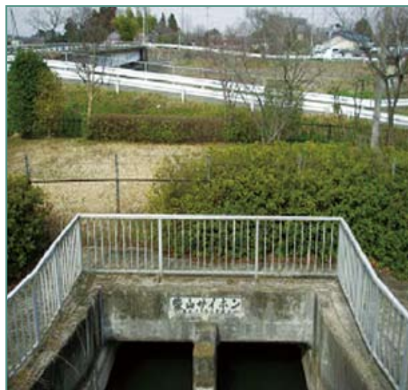
現在の柴山伏越（白岡町柴山、蓮田市上平野）。昭和57年、埼玉合口二期事業（水資源機構）により改築された。写真奥に元荒川が流れる。
