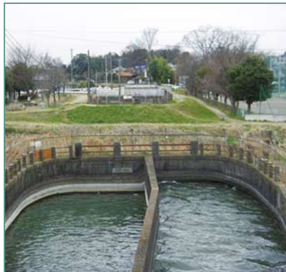
現在の瓦葺伏越（蓮田市蓮田、上尾市瓦葺）。綾瀬川の下を潜り流れている。
