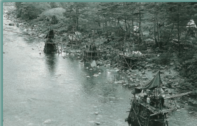
牧尾橋地点で実施されるボーリング調査
