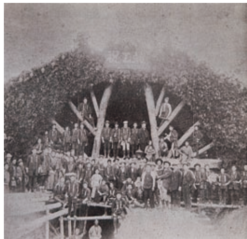
『大成建設土木史』に掲載された湊川隧道竣工時の様子。木製の支保工が見える。
