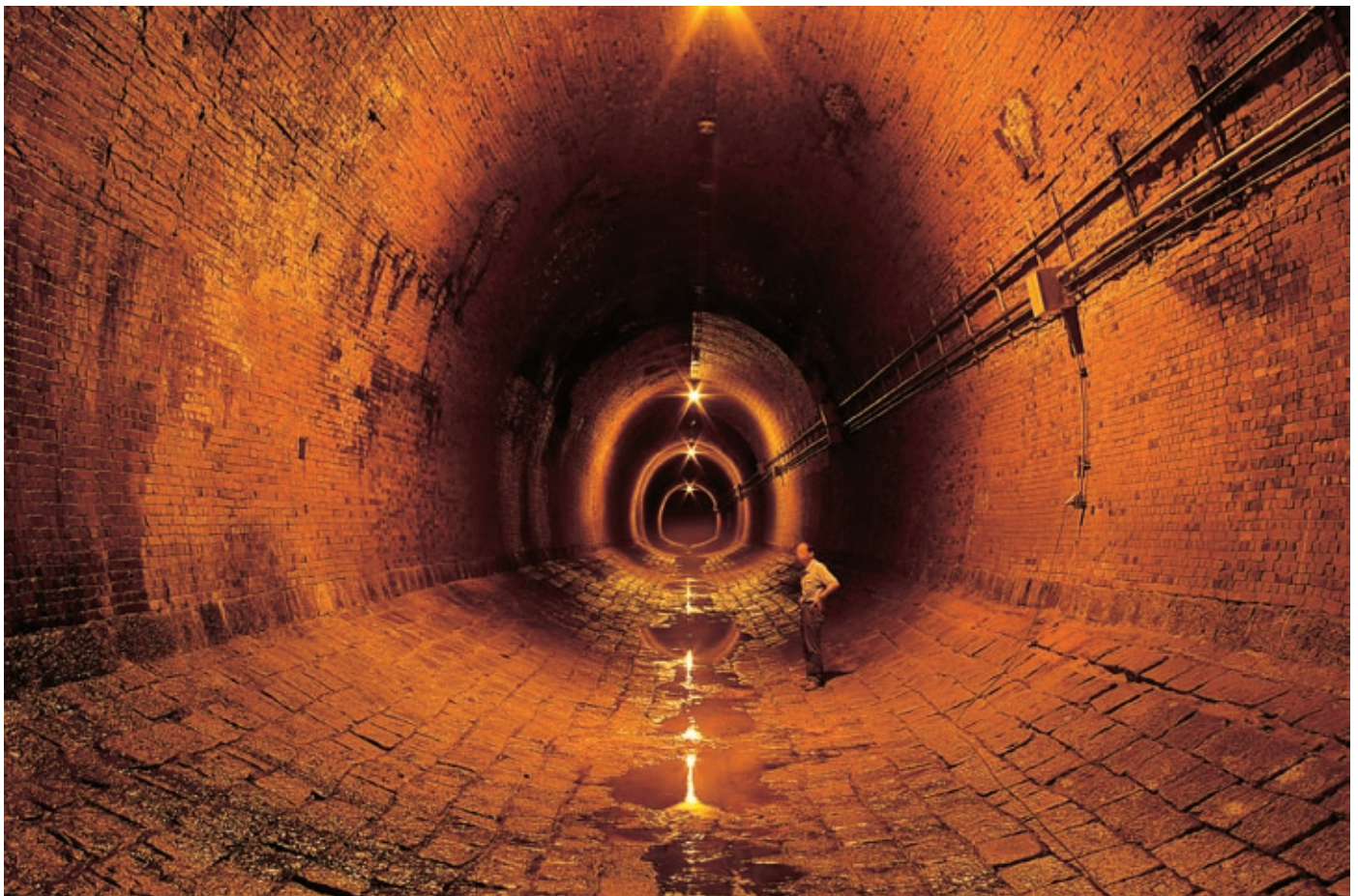
側壁とアーチ部にはレンガ、基底部には花崗岩の切石を張った巨大空間。おびただしい数のレンガや石材を手作業で一つ一つ積み上げていった人々の労苦が胸に迫る。土木学会の「現存する重要な土木構造物2800選」Aランク。
