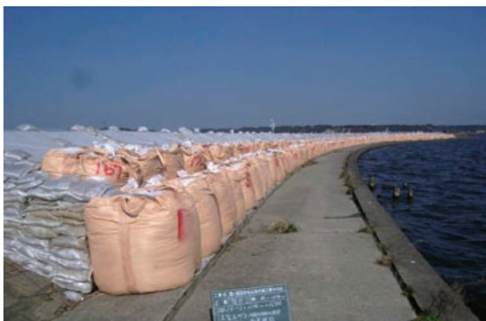
大型土のうで応急復旧した堤防（霞ヶ浦開発施設）
