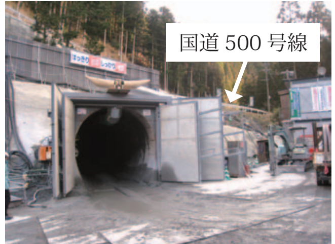
水浦水路トンネル施工状況(吐口側)
