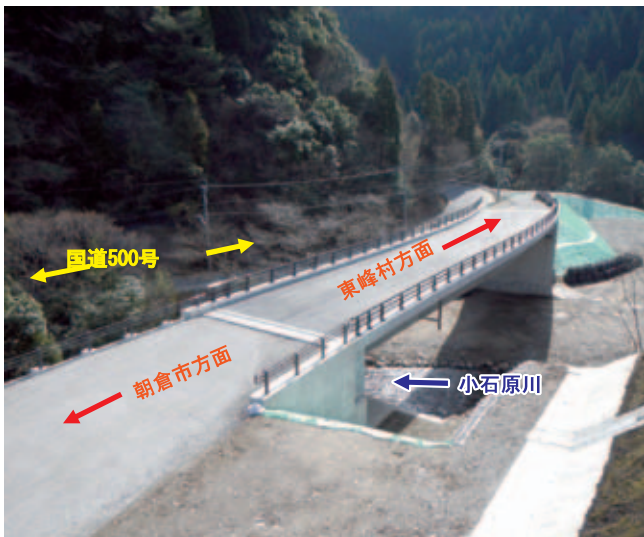
付替国道 5 号橋 (H25.3 完成)
