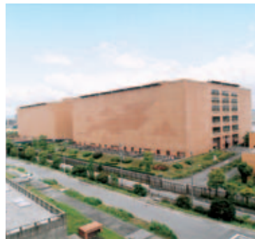
階層系浄水施設
