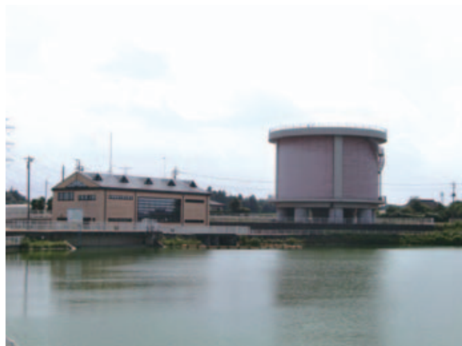
東山田調整池と揚水機場（古河市）
