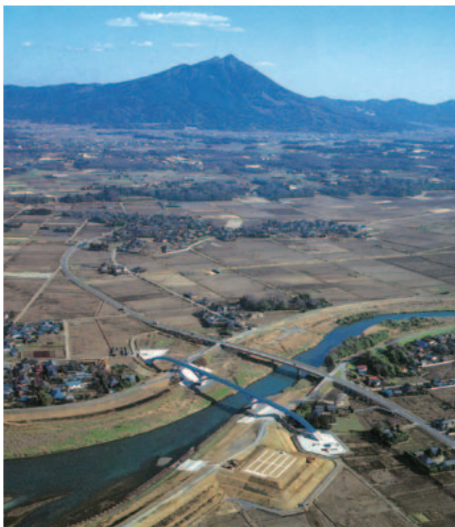
筑波山の裾野に広がる田園地帯と小貝川水管橋
