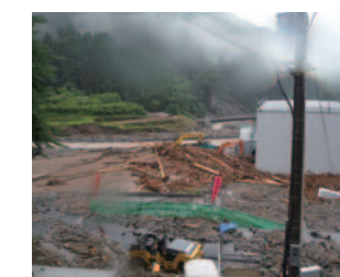
H29. 7.11 導水施設取水口
