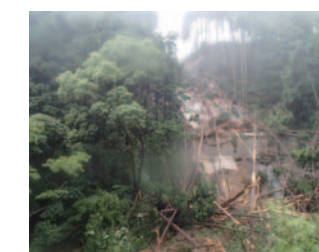
H29. 7. 8 工事用道路 (江川ダム貯水池左岸)
