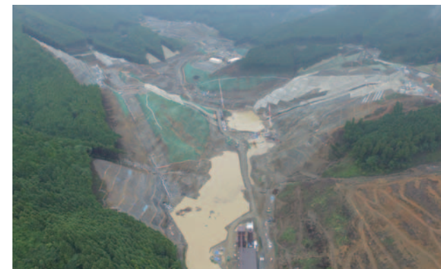
H29. 7. 8 UAVにより撮影したダムサイト水没状況 (撮影：鹿島・竹中土木・三井住友特定建設工事共同企業体)
