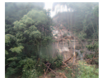
H29. 7. 8 工事用道路(江川ダム貯水池左岸)
