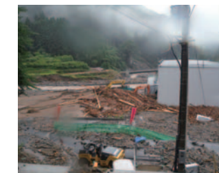
H29. 7.11 導水施設取水口
