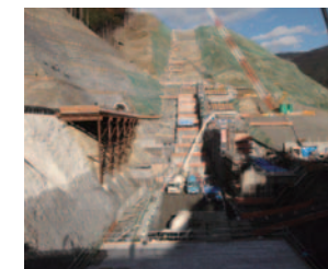
H29.12末 洪水吐きコンクリート打設状況
